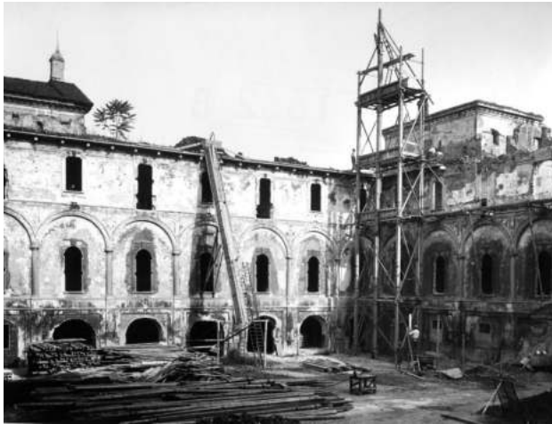
fig. 105 Lavori di recupero nel 1952 della caserma Villata per la trasformazione in museo (fonte: Archivio del museo, disponibile online).
